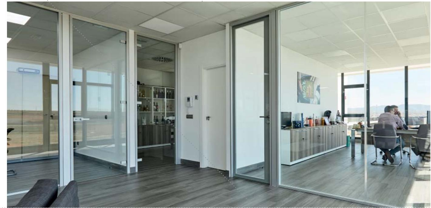
Las puertas vidriadas de suelo a techo dan amplitud al espacio de trabajo. En el despacho de dirección se instaló una puerta Biglass para obtener mejor aislamiento acústico.
