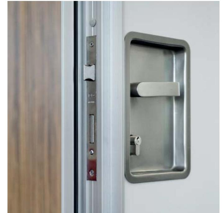
**La puerta del tabique móvil tiene el mismo espesor que el tabique. La maneta está enrasada con el panel para un mejor apilamiento de los módulos.**
