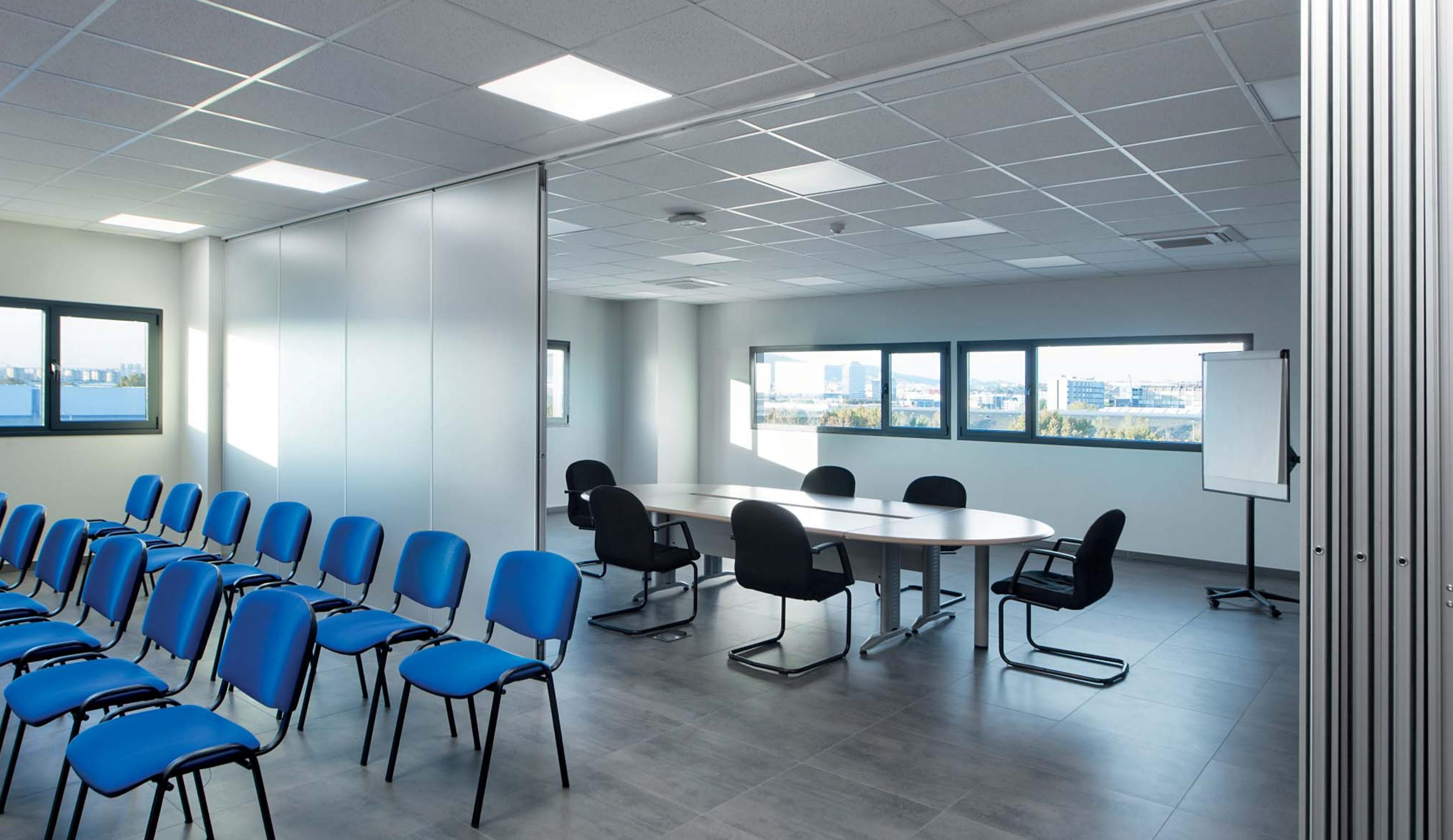
Los tabiques móviles se sustentan mediante una guía superior fijada al forjado ya que el peso del tabique es de unos 50kg/m2. Los módulos se fijan mediante un sistema telescopico oculto interior.
